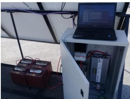
Figura 2. Baterías, cargador e inversor del sistema fotovoltaico.
