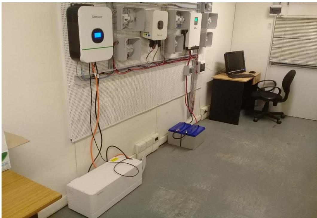
Figura 4. Módulo didáctico con la instalación de tres sistemas fotovoltaicos
