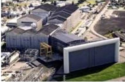
Figura 3 *Escala completa subsónica de retorno abierto (subsonic open return full scale)*
